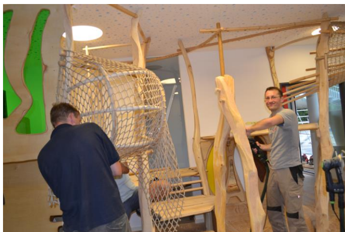
Eltern auf der Baustelle August 2013
